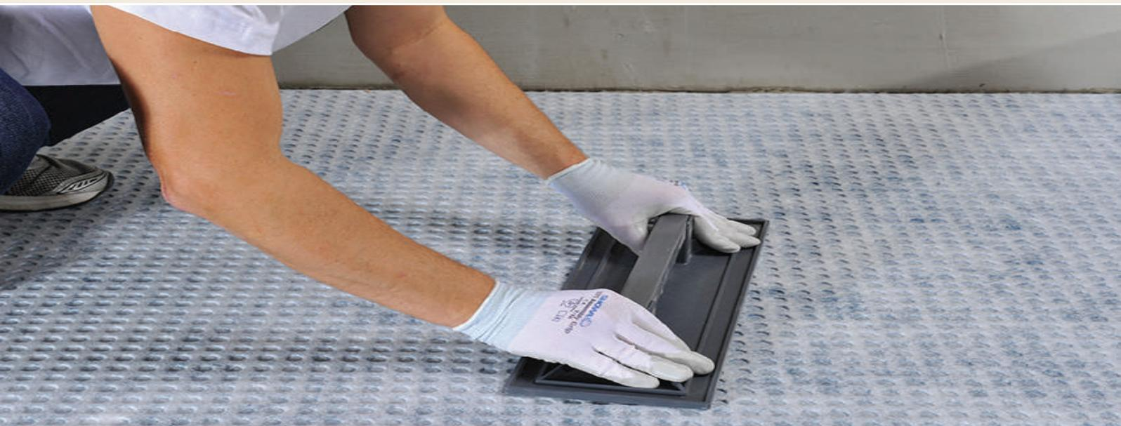
Disconnect è una membrana in polietilene a bassa densità provvista di cavità tronco piramidali a base circolare. La membrana è provvista inferiormente di un tessuto non tessuto in polipropilene termosaldato alla lastra in polietilene che garantisce il suo fissaggio al supporto; superiormente un tessuto non tessuto in polipropilene termo-saldato aderisce perfettamente alla lastra in polietilene garantendo l'incollaggio delle piastrelle
